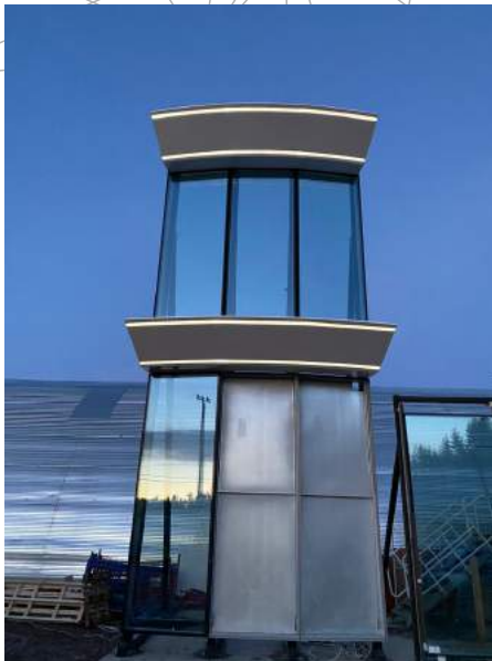
Mock-Up (Mock-Ups) - фрагмент фасада здания
